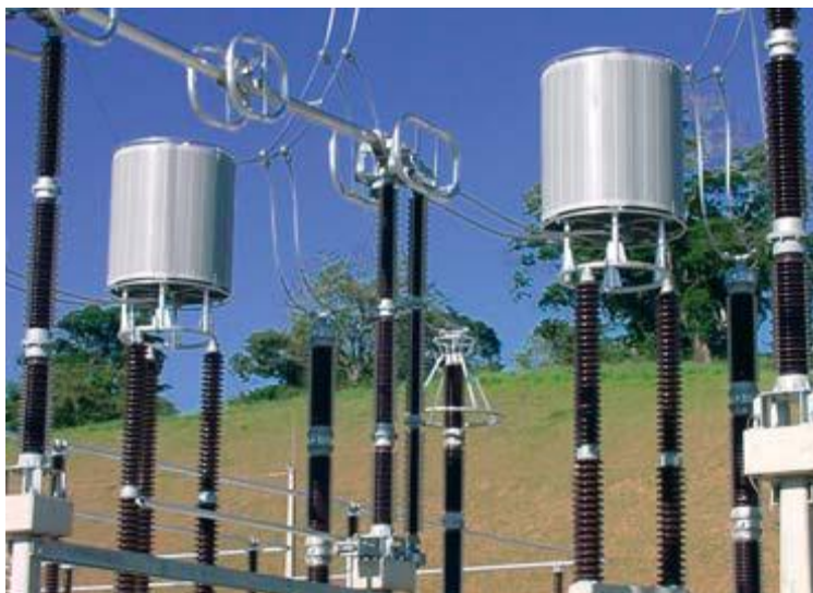
شکل ۱۳- نصب سری تله موج با خط
