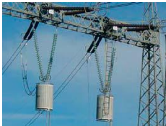
شکل ۱۵- نصب آویزی تله موج
