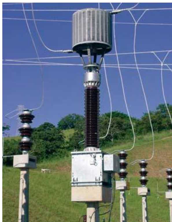
شکل ۲۱- نصب مستقیم یک تله موج روی CCVT
