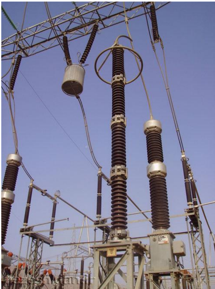
شکل ۱۹- خازن جفت‌کننده و تله موج در پست
